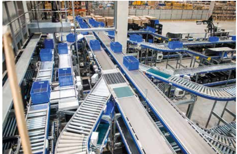
Swoboda planowania przy realizacji w nowym budynku (fot. materiały własne LLS)
